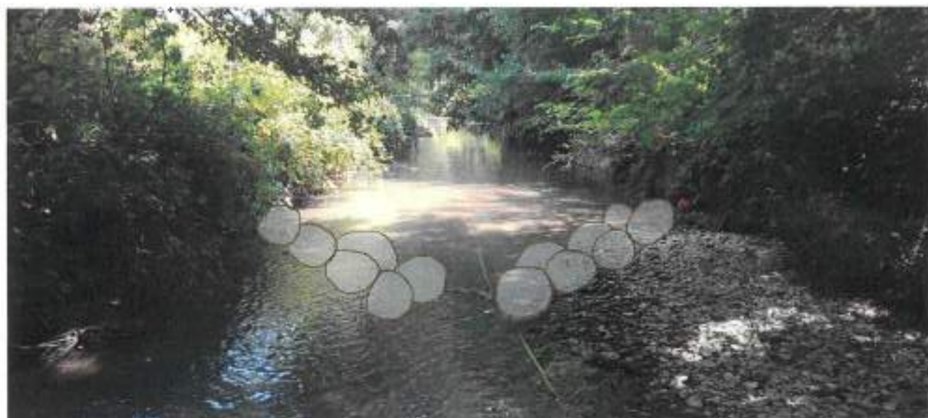
6) Aménagement 6: Double banquettes en vis à vis décalés. Banquette de 20 m de long sur 3,7 m de large en rive gauche et Banquette de 22 m de long sur 3,2 m de large en rive droite.
