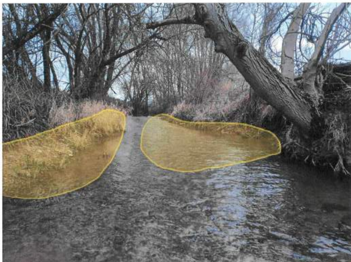
6) Aménagement 6: Double banquettes en vis à vis décalés. Banquette de 20 m de long sur 3,7 m de large en rive gauche et Banquette de 22 m de long sur 3,2 m de large en rive droite.
